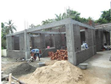
Bau 1tes Stockwerk
