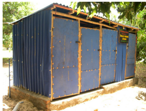
WC + Dusche. So wird in Indien gebaut, erfüllt aber ganz den Sinn und Zweck.
