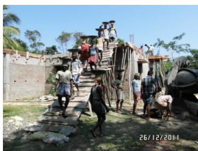
Betonieren der Decke
