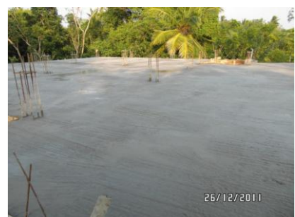
Decke betoniert
