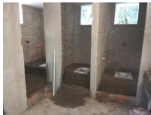
Toiletten im 1ten Stock
