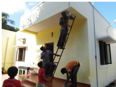
Installation der Überwachungskamera
