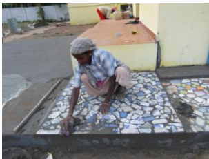
Die Terrasse wird betoniert
