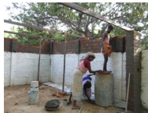
Die Garage wird gemauert
